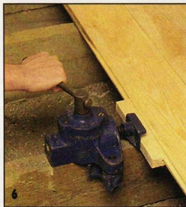
6 Для окончательного сплачивания настила используют специальные винтовые сжимы.
