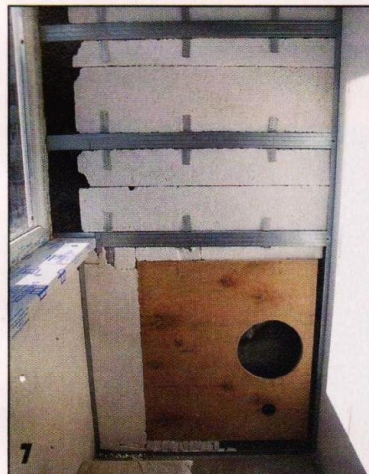
Утеплитель уложен, стена подготовлена к облицовке гипсокартоном.
