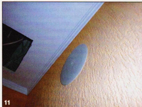
Стены покрыл декоративной штукатуркой «короед», а потолок покрасил белой краской.
