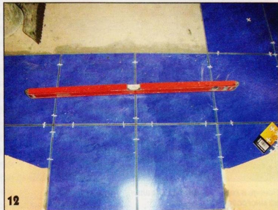
Укладка напольной плитки.
