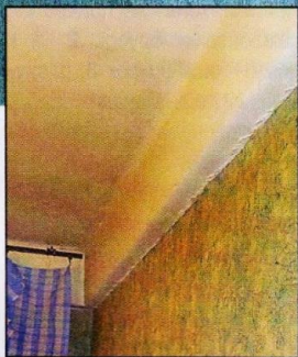
Балка до проведённого ремонта... интерьер явно не украшала.
