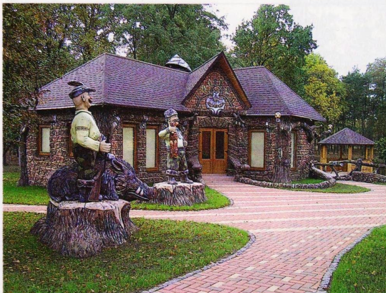
Охотхозяйство в Виннице. Забор сделан из сетки-рабицы, на которую набрасывали раствор. В основе столбов в виде деревьев — каркас из арматуры, обтянутый сеткой и забетонированный.
